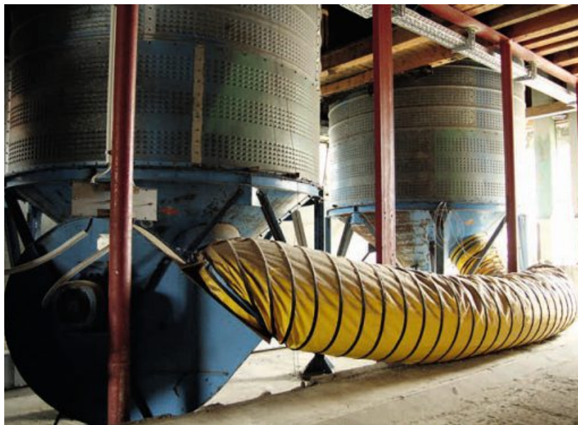
Nach einem ersten Reinigungsgang mit dem Siebreiniger lagert Landwirt Peter Heller seine Chargen in Hochsilos, die zentral belüftet werden.
