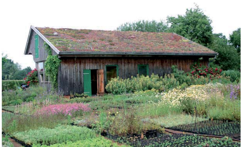
Ein grünes und blühendes Dach wirkt wie eine Tarnkappe – Gebäude werden optisch in die Umgebung integriert.
