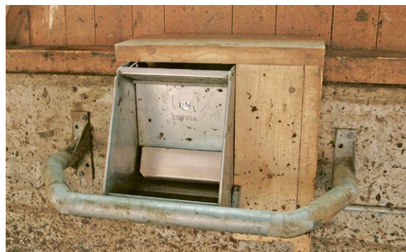
Verschmutzungen der Tränke durch Verkoten lassen sich durch einen Abweisbügel oder einen Sockel verringern. Die Tränke ist aber dadurch nicht zu verbarrikadieren und die freie Wasseraufnahme nicht zu stören.
