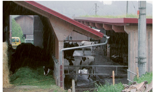
Die ungedeckte Fläche des Laufhofes ist in diesem Stall recht schmal und müsste je nach Anforderung verbreitert werden.
