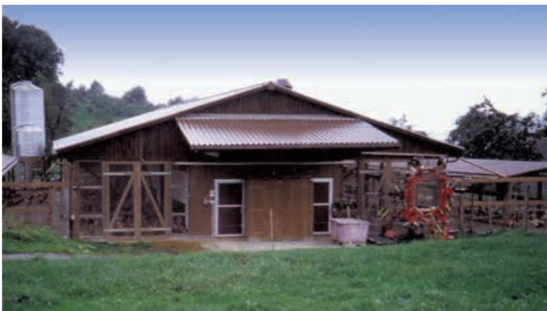
Außenklimabereiche auf beiden Seiten des Stalles ermöglichen eine bessere Nutzung des Grünlands in Stallnähe.
